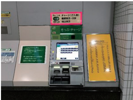
写真⑤ 壁開口箇所へ埋め込み設置した自動券売機
