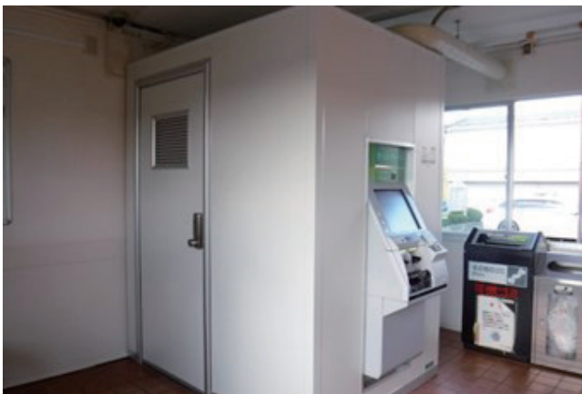
写真⑧ 屋内へ設置したプレハブ型券売機室 (風除室、積雪対応傾斜屋根なし)
