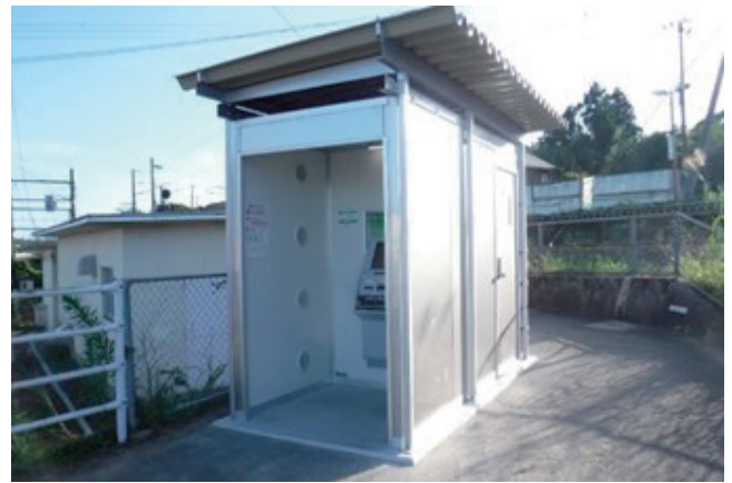
写真⑨ 屋外へ設置したプレハブ型券売機室 (風除室、積雪対応傾斜屋根あり)
